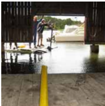
3. Båthusöppningen och -insidan muddras, pumpvattnet leds via en grov slang genom båthuset till fast mark.
