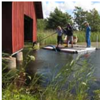
4. En person manövrerar pumpen och de två andra håller flotten på plats. En effektiv och enkel metod jämfört med muddring med grävskopa.
