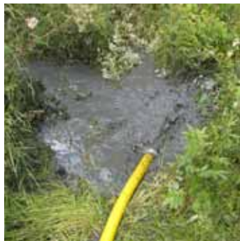
2. Dyvattnet leds ut på en höglänt plats med bra dränering. Kolla med din kommun vad som gäller för stt få tillstånd till muddring.
